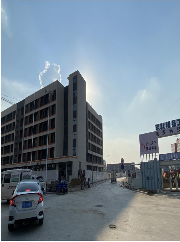
项目西南侧（其他在建项目）
