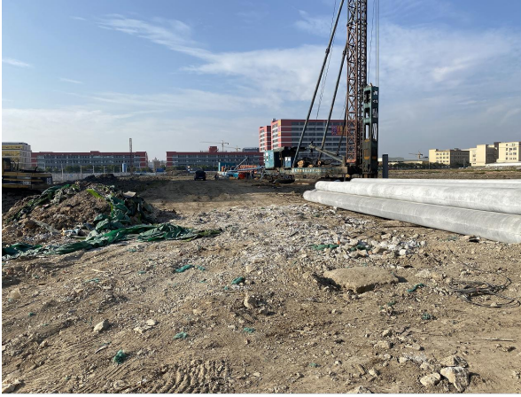
项目场地内部现状
