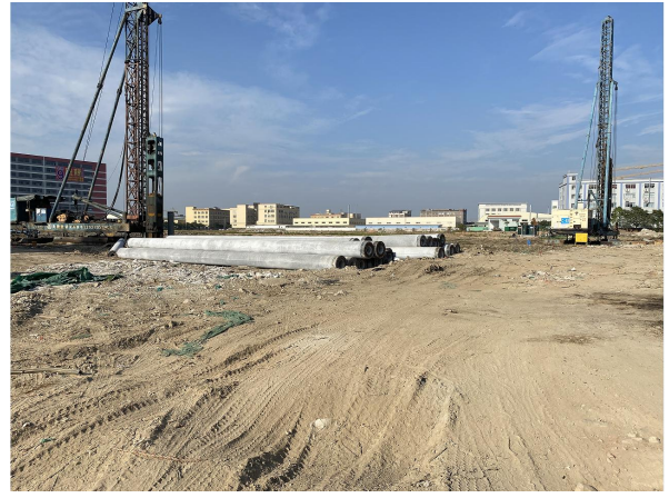
项目场地内部现状
