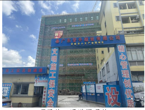
项目施工通道区现状
