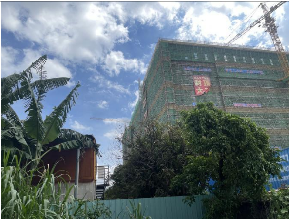
项目西北面现状（工业厂房）
