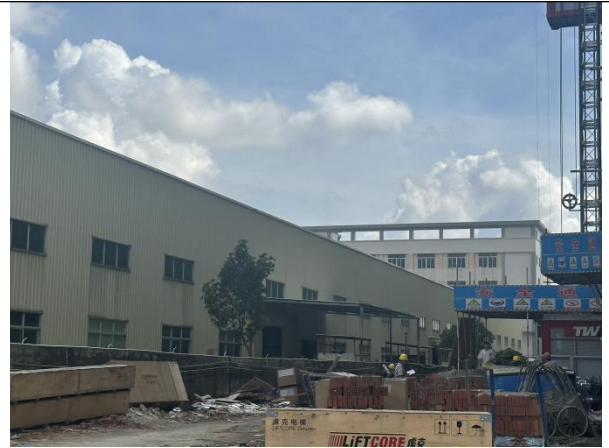
西北侧围蔽现状
