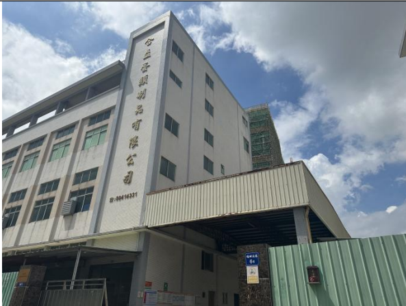
项目东北面现状（工业厂房）
