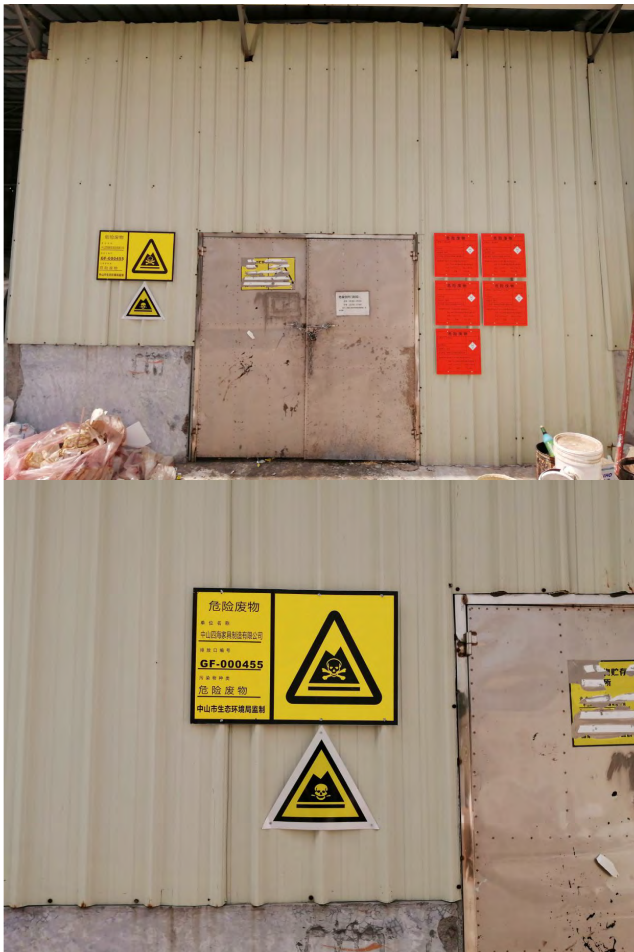
像4.1.4-1 危险废物贮存场所
