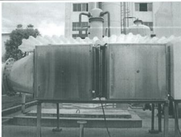
UV 光解净化器效果示意图
