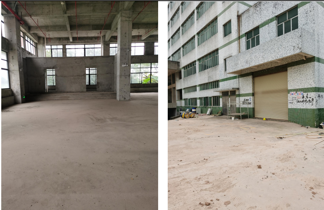
图 3 项目厂区硬底化照片
