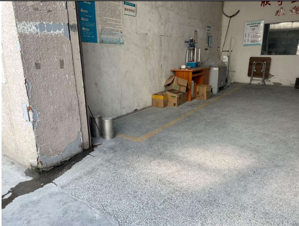
厂区硬底化照片
