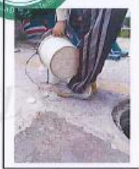
生活污水排放口
