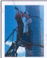
喷面漆及其自然晾干、漆磨工序废气排放口
