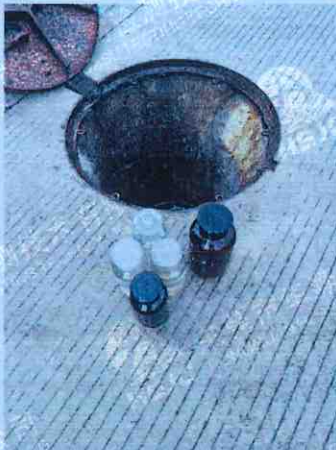
生活污水排放口
