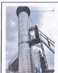
喷漆、烘干、自然晾干、移印、洗车水擦拭工序废气排放口 G2
