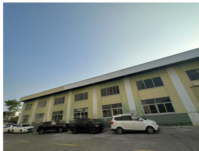
项目西面为空置厂房
