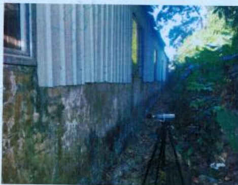
项目东南界外1米检测点 N3
