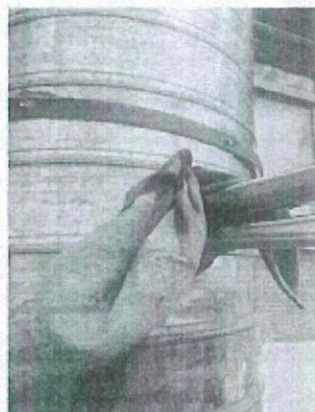
粗搅拌、研磨、细搅拌、清洗 废气、涂膜、烘干工序废气 排放口
