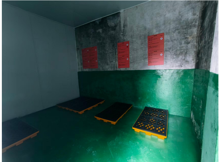
图 3-3 危险废物暂存区
